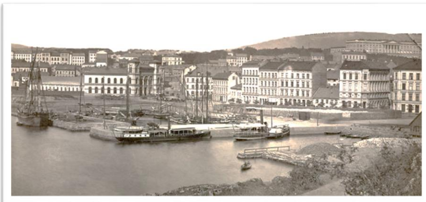
Da stasjonen til Drammensbanen (Vestbanen) ble anlagt i 1872, ble også bryggeanleggene utvidet, og småbåtene flytta til Filipstad. Det ble reist en murhusrekke foran småhusene, som fikk adresse Sjøgata. Da ble også vestbanestasjonen anlagt og husrekka i Sjøgata bygd for å skjule Vikabebyggelsen for ankommende gjester. Bildet er antakelig tatt i 1877. Foto: Olaf Martin Peder Væring/Oslo museum.
